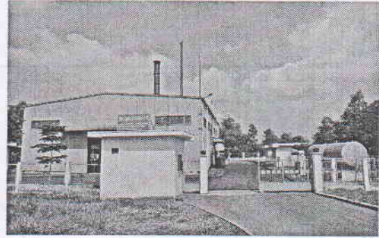
Trạm Xử lý rác y tế
